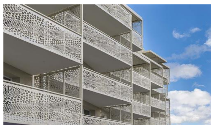
Logement locatif rénové à Givors
